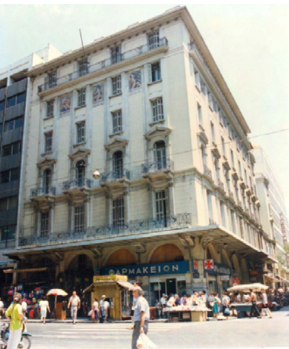
Μ.Τ.Π.Υ. - Αποκατάσταση, Επισκευή & Αναδιάρθρωση κτιρίου
