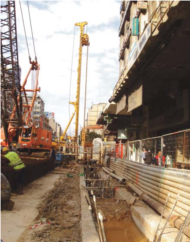
Μετρό Θεσσαλονίκης - Τοποθέτηση Διαφραγμάτων
