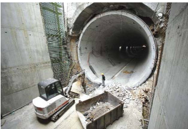
Μετρό Αθήνας - Γραμμή 2 Σήραγγα με εκσκαφή & Επανεπίχωση
