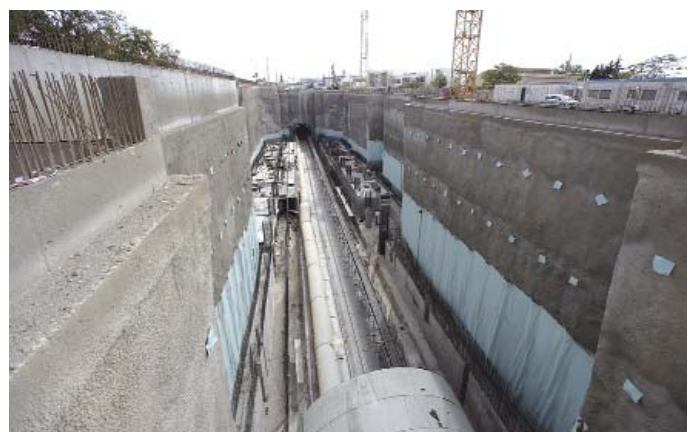
Μετρό Αθήνας - Γραμμή 3 Σήραγγα με εκσκαφή & Επανεπίχωση
