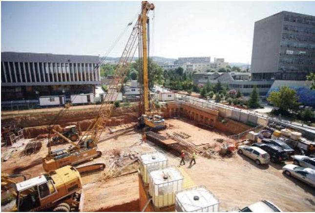
Μετρό Θεσσαλονίκης - Σταθμός Πανεπιστήμιο
